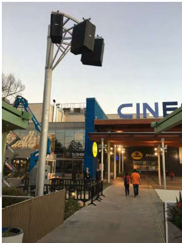
Montaje estructuras soporte sistema sonido C.Comercial Parquesur – Leganes (Madrid) 2017
