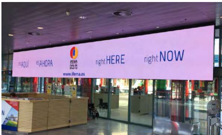
Montaje estructuras pantallas IFEMA
